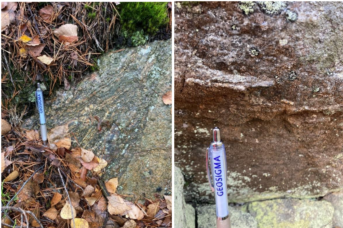
Figur 6-5. Rostpåverkan på sprickplan vid Lokal 7 i område C (t.v.) samt vid Lokal 9 i område E (t.h.).
